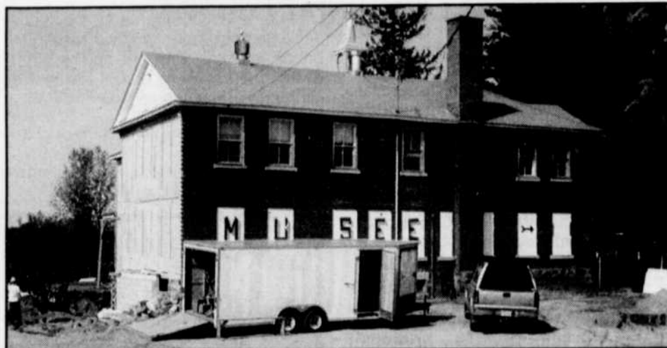
LE MUSÉE DES ABÉNAKIS d' Odanak en plein travaux
