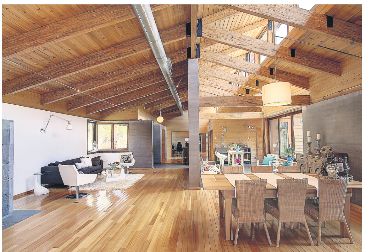
Il y a 22 poutres qui soutiennent la maison. Les murs en pisé de terre sont aussi porteurs. Ici, une vue du salon, de la salle à manger et de la salle de séjour.
