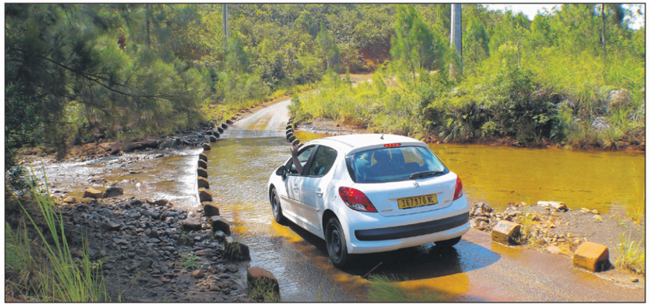
Sur les routes de montagne, on prend plaisir à traverser les passages à gué bordés par de petits créneaux laissant passer le ruisseau ou la rivière.
