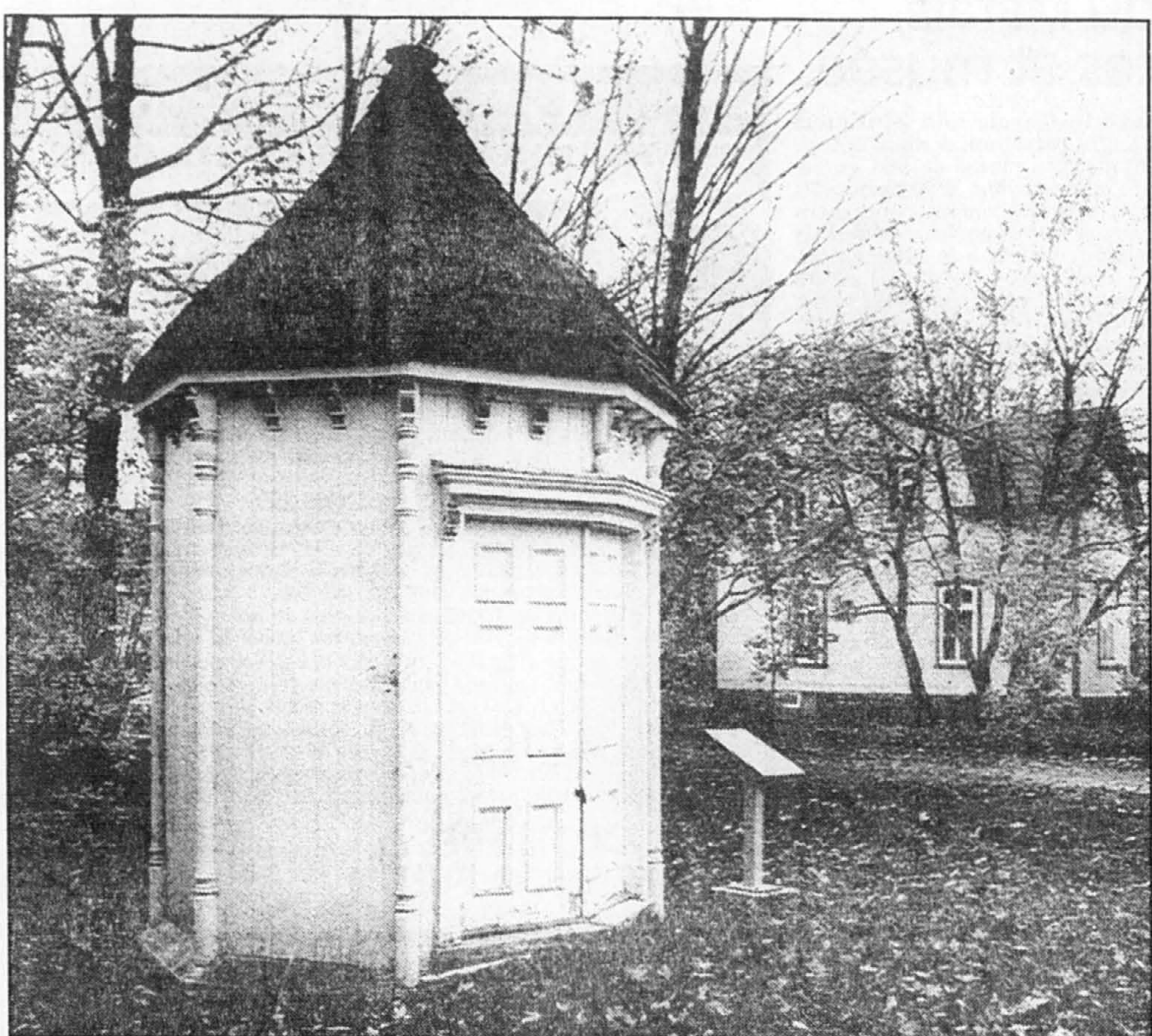
Coiffé d'un toit à l'impériale, le petit bâtiment de bois construit en 1889 évoque les kiosques et pavillons de l'ère pittoresque. À noter les élégantes consoles sculptées qui supportent le toit recouvert de bardeau.
