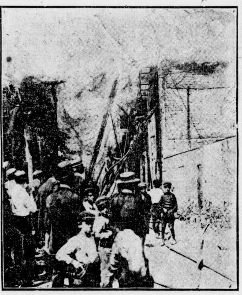
Le feu dans les automobiles. Une vue de l'établissement de la rue Stanley, durant l'incendie, à midi.
