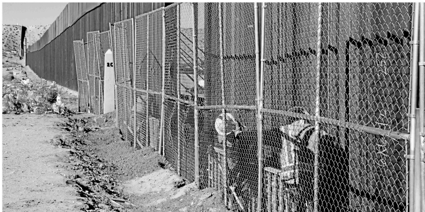
Des ouvriers étaient déjà à l'œuvre pour construire une clôture plus haute dans la région entre les villes d'Anapra, au Mexique, et de Sunland Park, aux États-Unis. — PHOTO AP, CHRISTIAN TORRES
