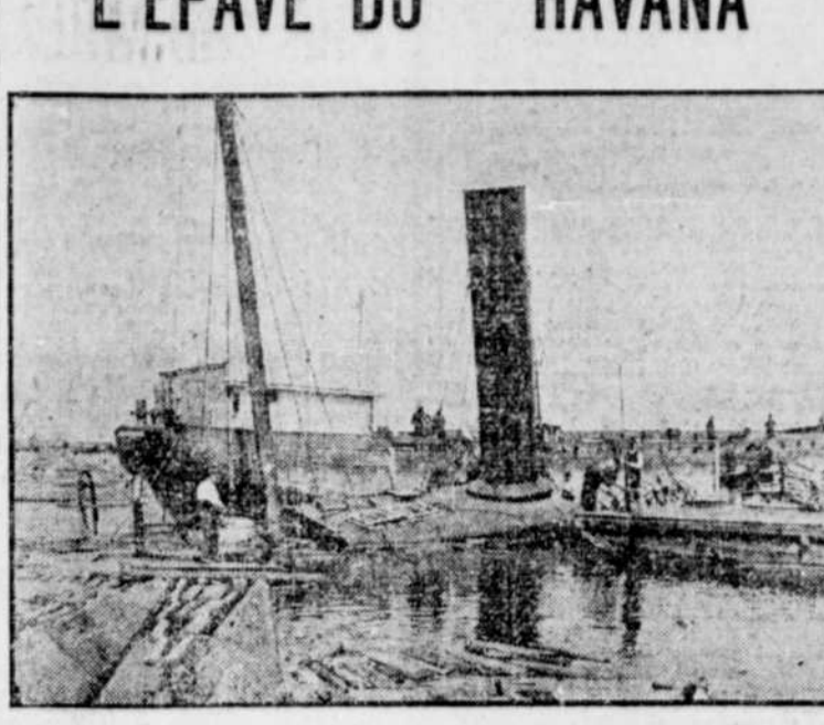
La poupe du steamer "Havana", complètement submergée, au bout du quai Bickerdike. Il y a quatre pieds d'eau sur le pont, en arrière de la cheminée.
