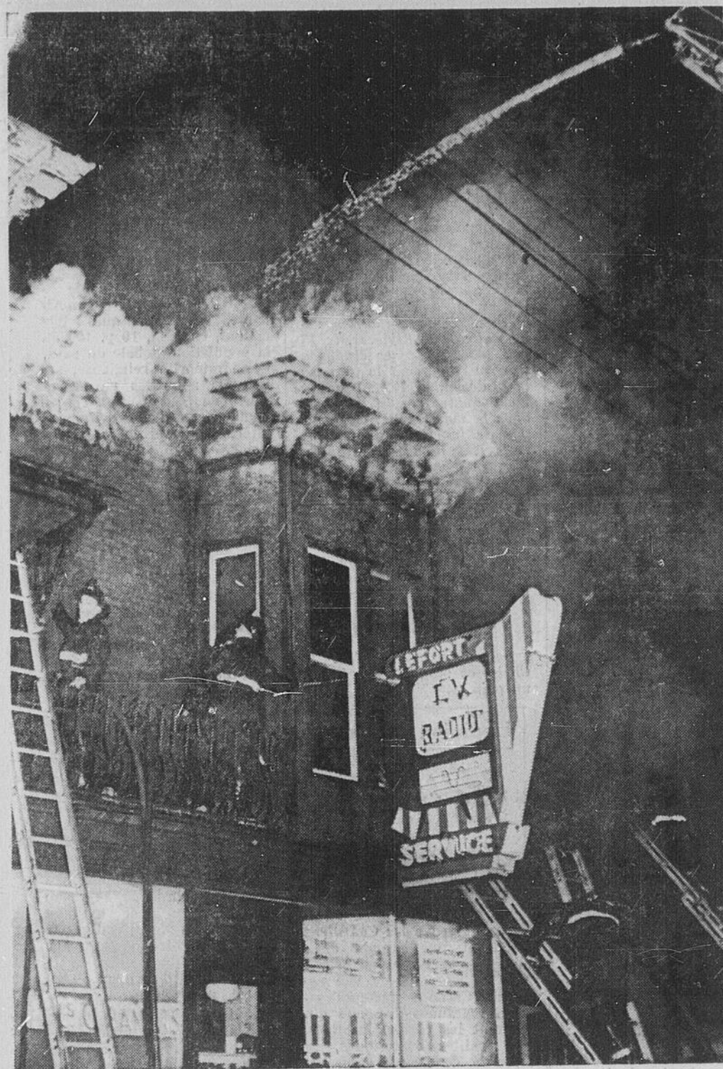
VIOLENT INCENDIE A HULL — Les pompiers de Hull ont dû combattre ferme pendant plus de deux heures, dimanche soir, afin de circonscrive les flammes d'un incendie qui a causé pour près de $50,000 de dommages à un édifice commercial, situé sur la rue Eddy, entre les rues Wright et Hôtel-de-Ville. Par moments, les flammes s'élevaient à plus de 20 pieds dans les airs, offrant aux quelque 500 spectateurs de riverains émotions. (Voir nouvelle et autre photo en page 13) (Photo Champlain Marcell)
