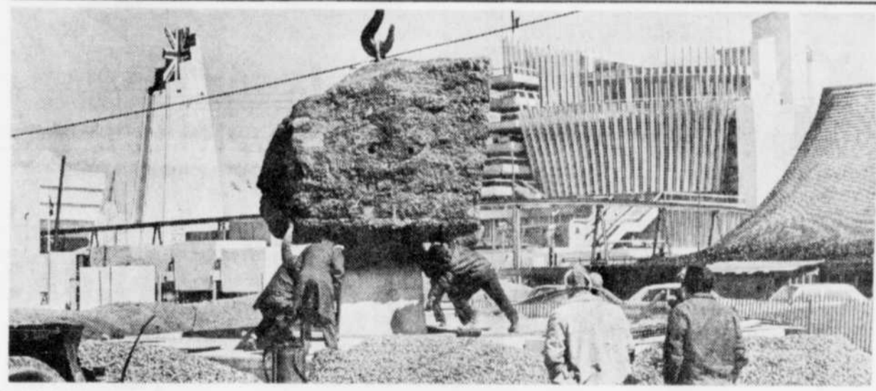
DANS L'ÎLE NOTRE-DAME — A l'Expo 67, des ouvriers posent sur son socle, à la Place de l'Amiante, dans l'île Notre-Dame, le bloc de minéral d'amiante de 45 tonnes, extrait dans les Cantons de l'Est du Québec. L'énorme roche qui ruissellera est l'élément-clé de la Place, un endroit de détente commandité par l'Association des Mines d'amiante du Québec.
