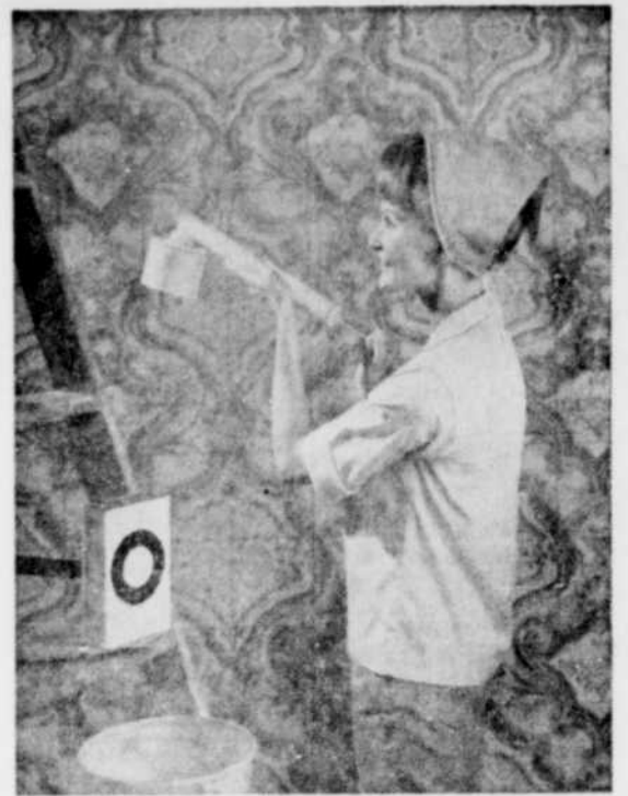
Pour enlever le vieux papier-tenture. Utilisez le vaporisateur à insectes et mettez-y un mélange d'eau chaude et une partie égale de détergent à lessiveuse automatique et de bicarbonate de soude.
