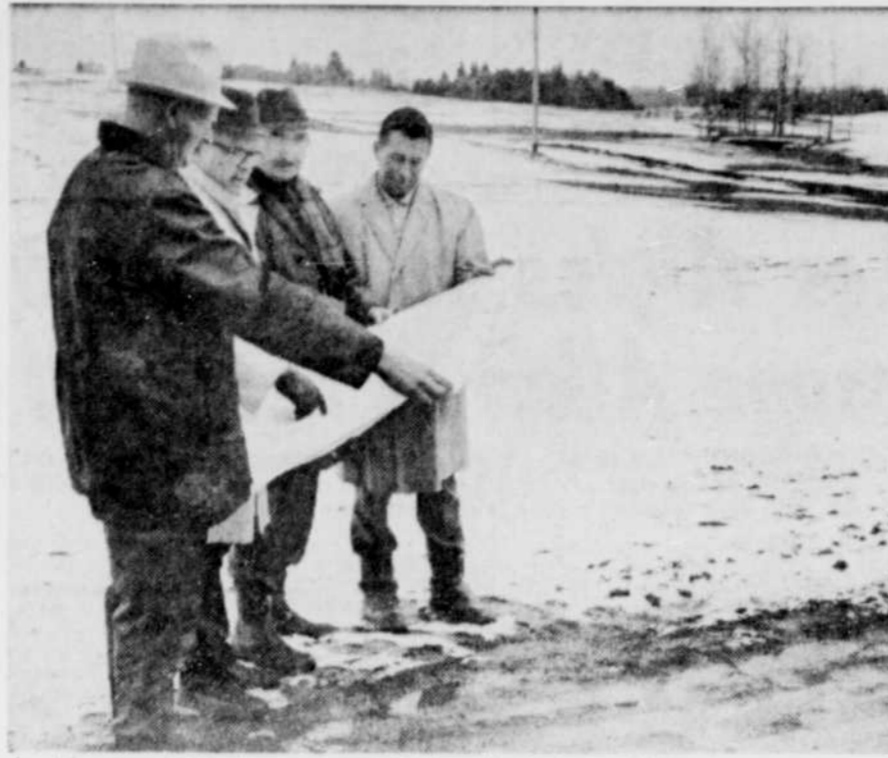
Les travaux ont débuté au nouveau club de golf de Lennoxville pour porter de neuf à dix-huit trous le terrain en vue de la saison '68. La photo nous montre ici les responsables de la construction: Len Bowers, Charles Warner, président du comité de construction, Howard Watson, président de Canadian Golf Landscaping Limited et Gilles Dubé, membre du comité de la construction. La direction envisage de terminer les travaux à l'automne.
