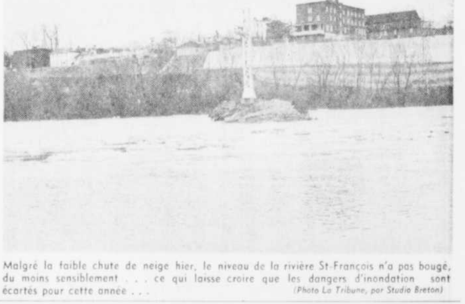
Malgré la faible chute de neige hier, le niveau de la rivière St-François n'a pas bougé, du moins sensiblement... ce qui laisse croire que les dangers d'inondation sont écartés pour cette année...
