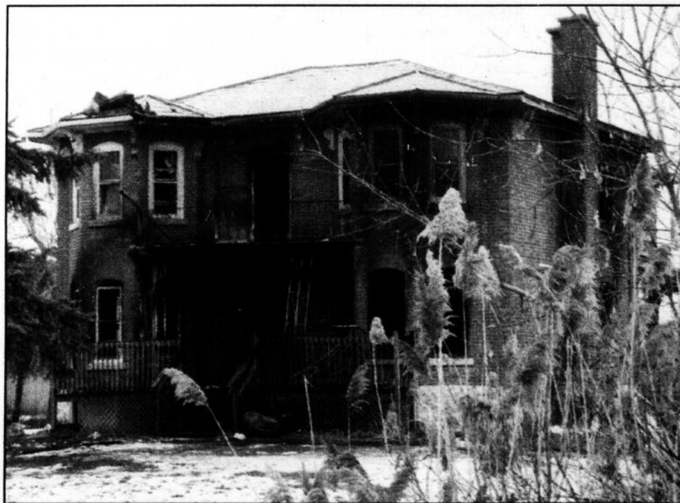
Selon le chef de la brigade contre les incendies de Howick, l'intérieur de la partie avant de la grande habitation fut grandement détruite et il semble peu probable qu'elle soit reconstruite. La structure, qui fut à l'origine une imposante résidence familiale, a servi pendant plusieurs années d'espaces à bureaux pour l'usine adjacente Martin & Stewart Hides and Skins. (photo J.T.)
