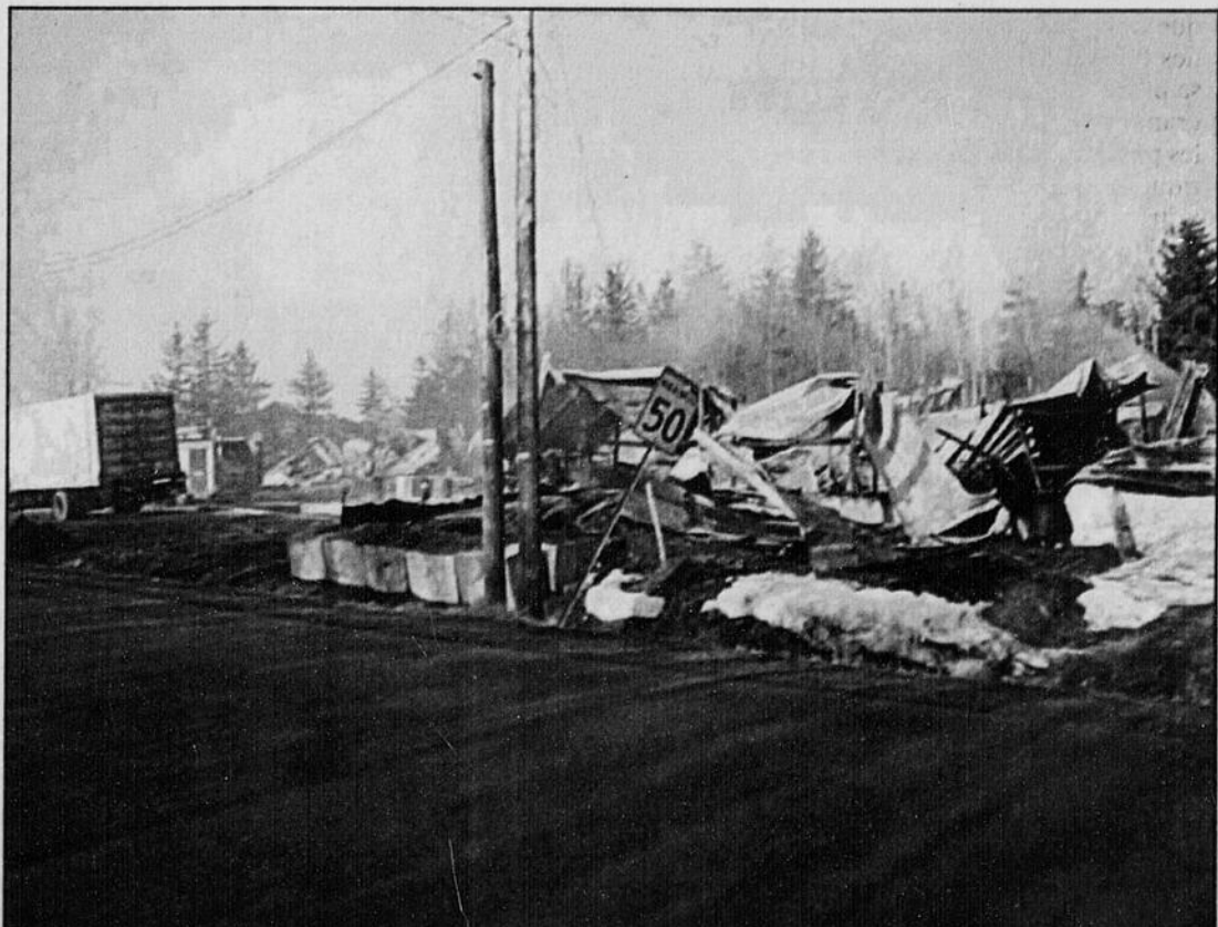
Le feu n'a pas laissé grand-chose du vaste entrepôt construit l'automne dernier par Rock et Suzanne Simard en bordure de la rue Saint-Michel, à Omerville.
