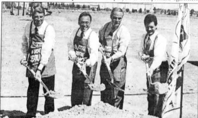
Ils ont procédé à la pelletée de terre inaugurale des travaux de construction du Réno-Dépôt, boulevard de la Carrière, à Hull : Pierre Michaud, président Réno-Dépôt, le maire hullois Yves Ducharme, Yves Archambault, président Réno-Dépôt, et Denis Dutrisac, directeur du futur magasin.
