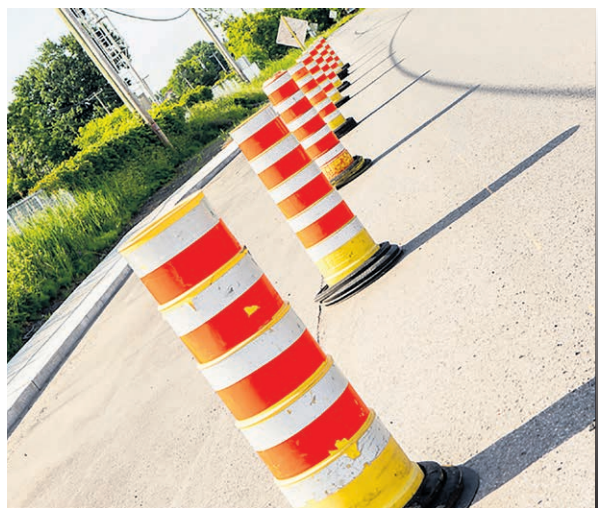
Travaux sur une vanne souterraine à Terrebonne.
