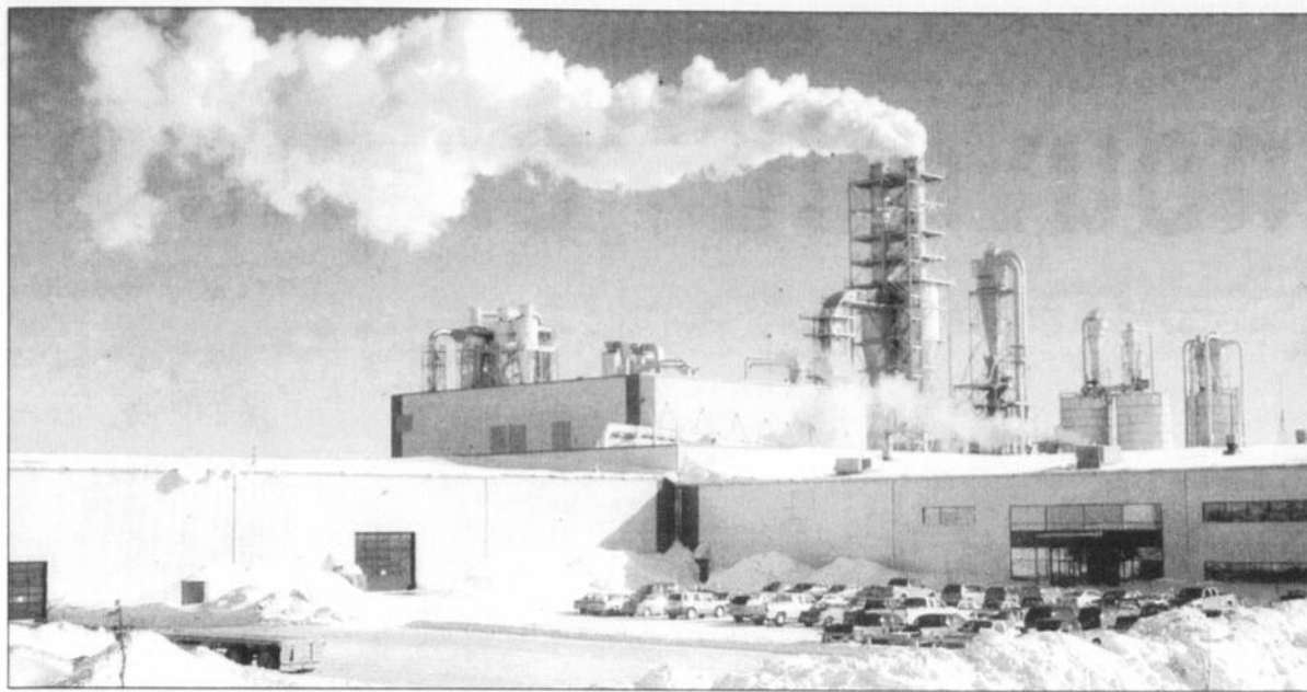
USINE - L'usine MDF de La Baie semble vouée à un bel avenir.
