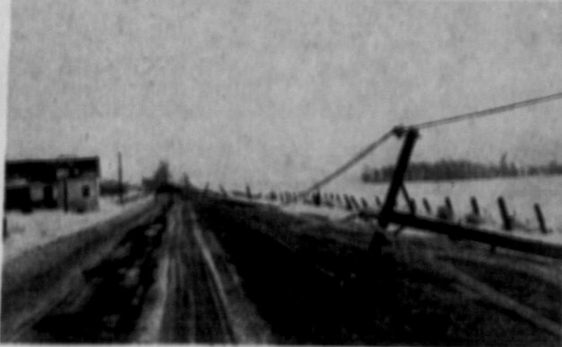
C'est le secteur Soulanges qui a été le plus durement et le plus longuement touché par les pannes de courant. Certains poteaux n'ont pas résisté à l'assaut et au poids du verglas. (Photo Le Soleil)
