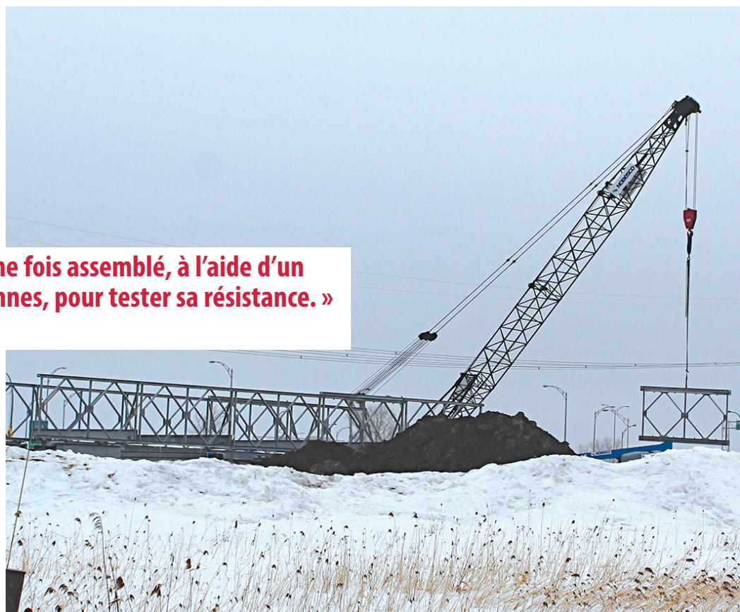
Le pont modulaire est assemblé dans le secteur de l'échangeur des autoroutes 10 et 35. (Photo : Frédéric Khalkhal)
