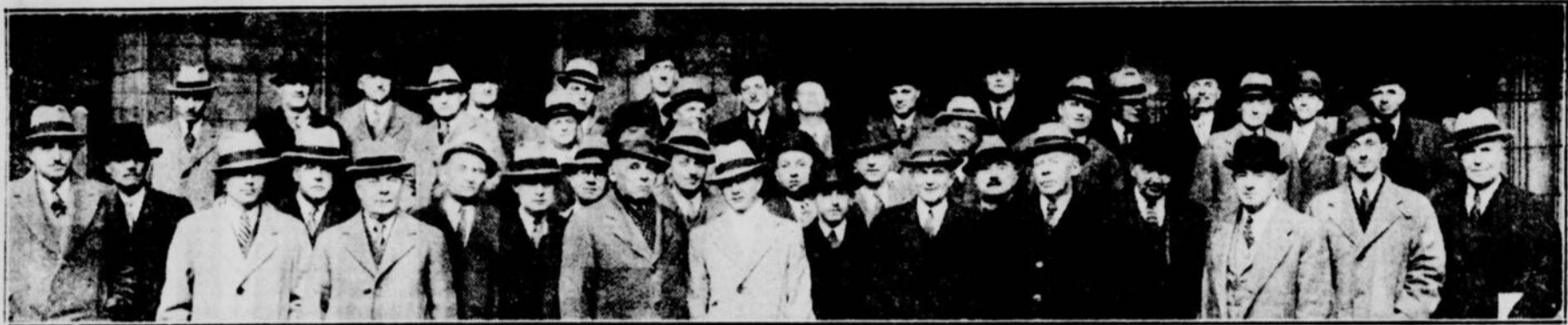
Membres de la délégation des représentants des intérêts miniers du nord-ouest du Québec, qui se sont présentés mercredi devant le premier ministre Duplessis pour réclamer la construction d'une route d'hiver entre St-Félicien et la région de Chibougamau. Les délégués se réunirent ensuite au Château Frontenac devant l'entrée duquel ils sont ici photographiés, à l'issue d'un lunch que présidait M. J.-C. Lamothe, C.R. président de la Obalski Mining Corporation et auquel l'honorable Onésime Gagnon était l'invité d'honneur. Première rangée, de gauche à droite: M.M. J.-B. Tremblay; R. Morris, de Garneau et Ostiguy; J.-A. Roy, de la "Patrie"; Donat Marcotte, Burke Dansereau & Co.; E. Dallaire, président Chambre de Commerce de Grand'Mère; W. McKenzie, de McKenzie & Co.; M. Boivin; J.-C. Lamothe, C.R.; W. Wisely Bragg; J. Scanlon, du Financial Times; J.-N. Giroux; A.-M. Bloomfield; et A.-C. Corder, 2ème rangée, dans le même ordre: A. Sniard, A.-J. Hirst, Macaboug Explorations Ltd.; L.-D. Fortin, W.-J. Brennan, de W. McKenzie & Co.; D. Farber, de McKenzie Co.; R. Belgrave, de McKenzie Co.; J.-Austin Murphy, président de Chibmac Mines, Ltd.; 3ème rangée: A. Trudel, "Le Petit Journal"; F.-J. Sharp, Thomson Mathewson & Co.; W.-H. Schmidt, Capital Rouyn et Carth Chibougamau; R.-B. Wightman, Consolidated Mining and Smelting Co. Ltd., Consolidated Chibougamau Goldfields, McKay (Quebec) Explorations Ltd.; F.-F. Fields, "Montreal Herald"; Henri Gagné; William Selaton, Gold Magazine; W. W. Marshall, of W. McKenzie & Co.; Gab. Chartrand, Les Mines Canadiennes; Geoffrey Porteous, of W. McKenzie & Co.; P. G. McKenzie, Chibougamau Mining Properties; G.-A. Challen, The Quebec Miner; Robert Soden, L'Illustration Nouvelle; P. M. Shannon; Dr Léon Duguay, M.A.L.; Charles Mortoise et Armand Lévesque. — (Photo Canadien Pacifique).
