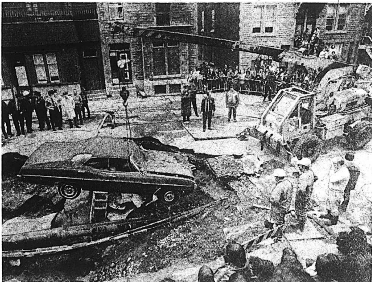
Résultat d'une inondation
