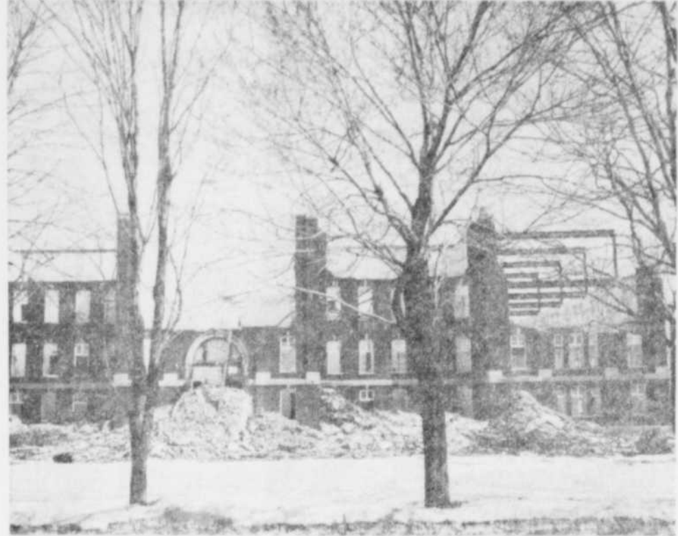
(Photo J.L.C.) L'ÉCOLE NORMALE de Nicolet disparaîtra complètement de la ville de Nicolet d'ici la fin du mois d'avril. La maison Panzini Ltée démolit actuellement cet édifice évalué à plusieurs centaines de mille dollars. L'école normale a servi la cause de l'éducation durant près de 50 ans.
