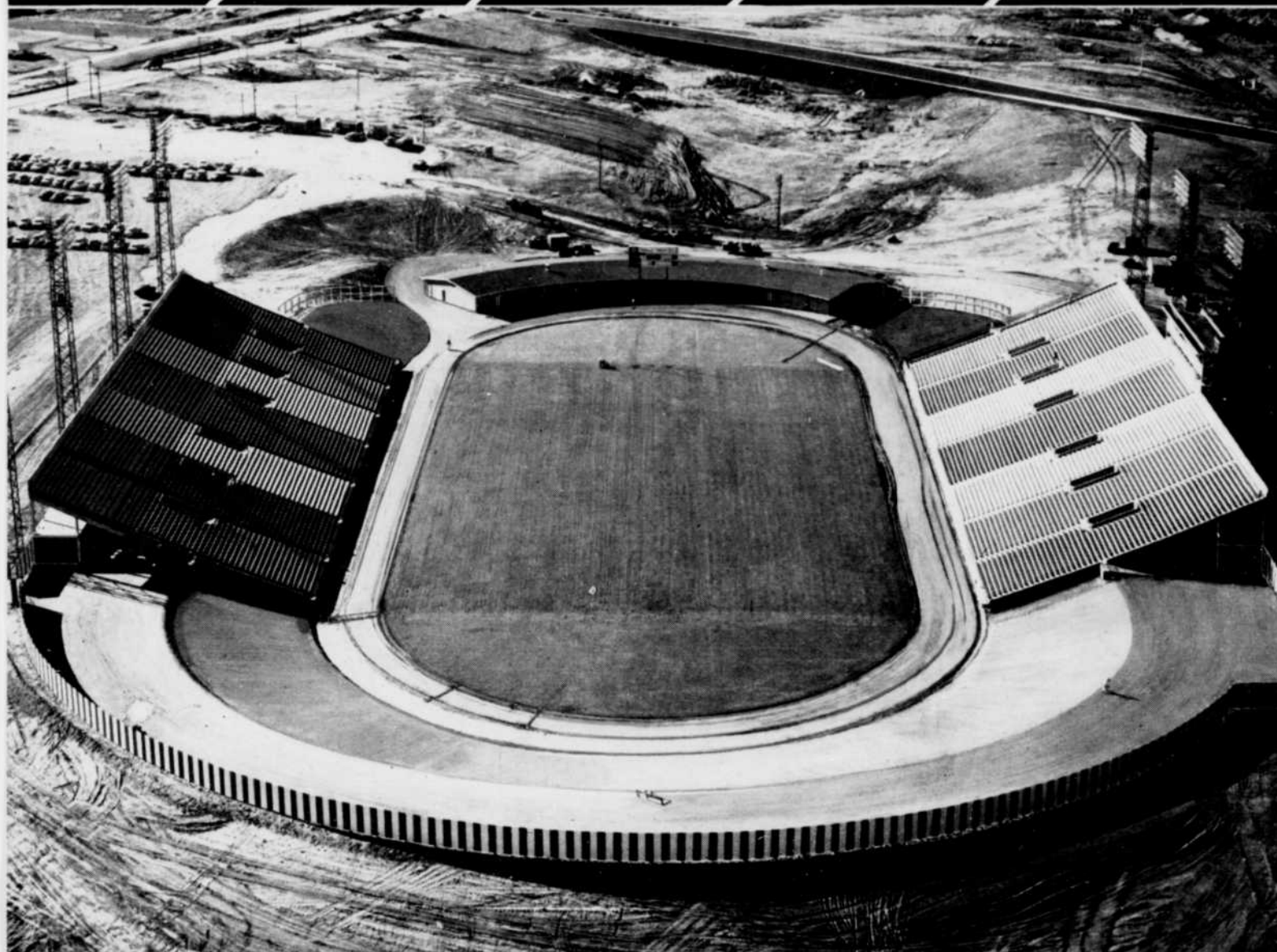
STADE McMAHON — Architectes: Rule, Wynn & Rule. Entrepreneurs généraux: Burns & Dutton Concrete & Construction Co. Ltd. Manufacturier et érecteur des éléments en béton préfabriqué et précontraint: Con-Force Products Ltd.
