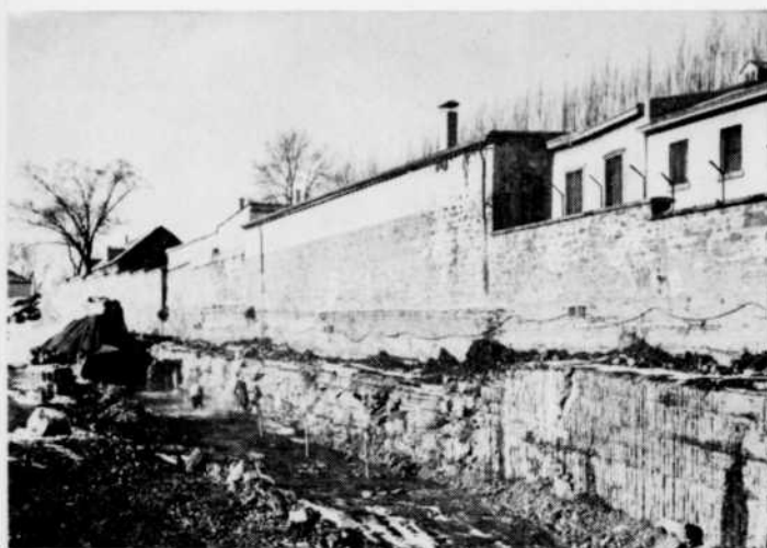
UN DYNAMITAGE FRACTIONNÉ a produit ces résultats excellents en bordure du mur centenaire de l'hôpital Hôtel-Dieu.
