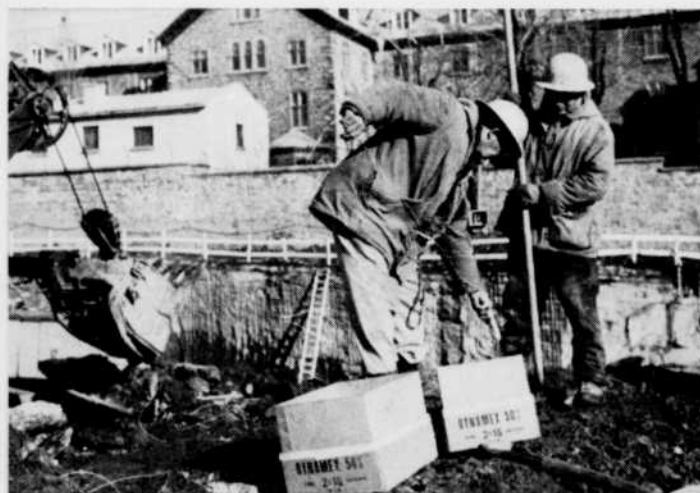
POUR AMOINDRIR LE CHOC, on s'est servi dans tous les travaux d'excavation, de l'économique DYNAMEX 50% et de détonateurs C-I-L SHORT-PERIOD.
