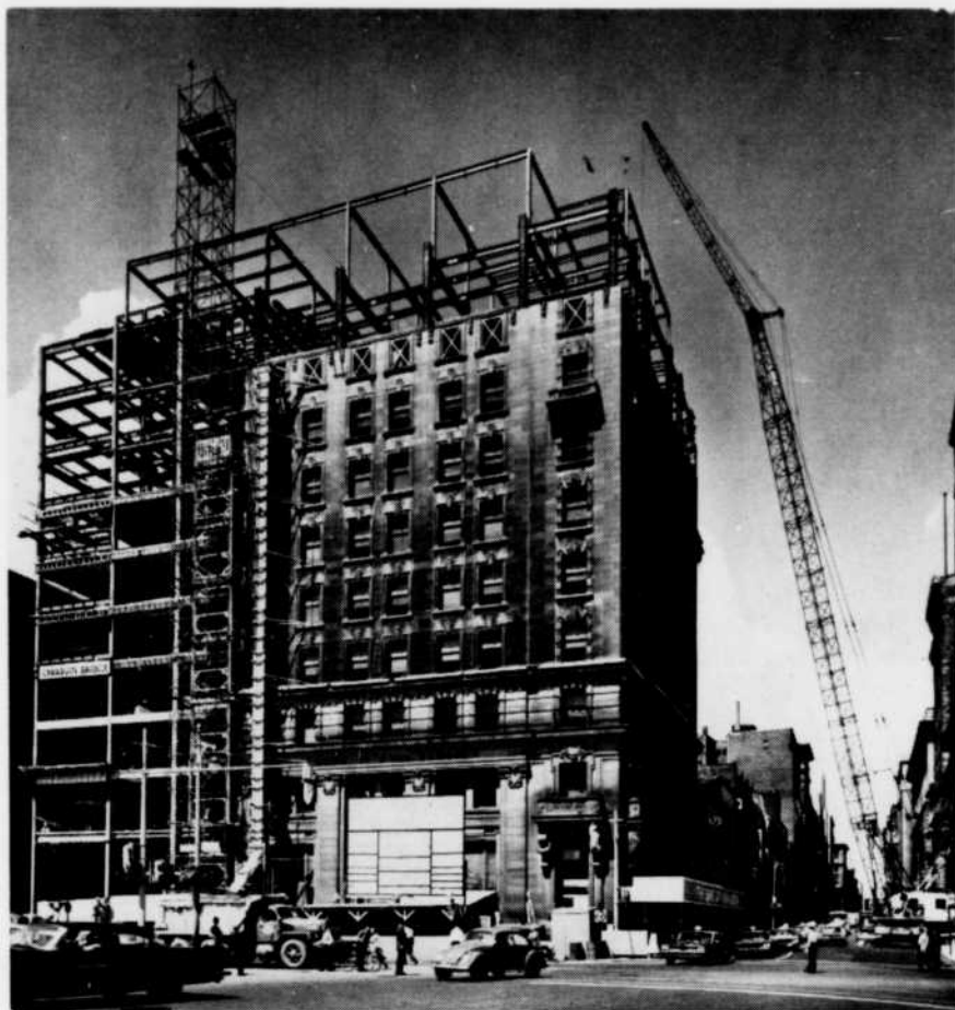
L'édifice de la Banque de la Nouvelle-Écosse, place Victoria, à Montréal, subit une transformation complète. On y ajoute un étage, puis on le flanque d'une extension de 11 étages. L'intérieur de l'immeuble sera également transformé pour permettre un meilleur usage de l'espace utile. On procède ici à l'érection de la charpente d'acier.
