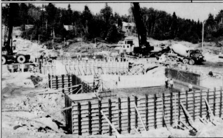
Le bétonnage des fondations du nouveau barrage no 7.
