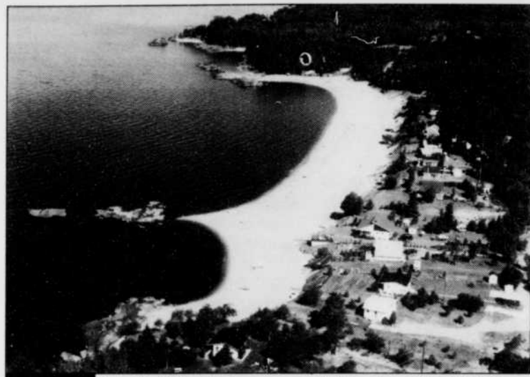
Près de 85 % des travaux projetés entre 1996 et 2006 sur les berges du Lac Saint-Jean consistent à l'entretien de rechargement de plages et des ouvrages de perrés et de pierre effectués entre 1986 et 1996. Cette photo nous montre d'ailleurs une plage rechargée à St-Henri-de-Tailon, dans la Baie Pascal, réalisé en 1989.
