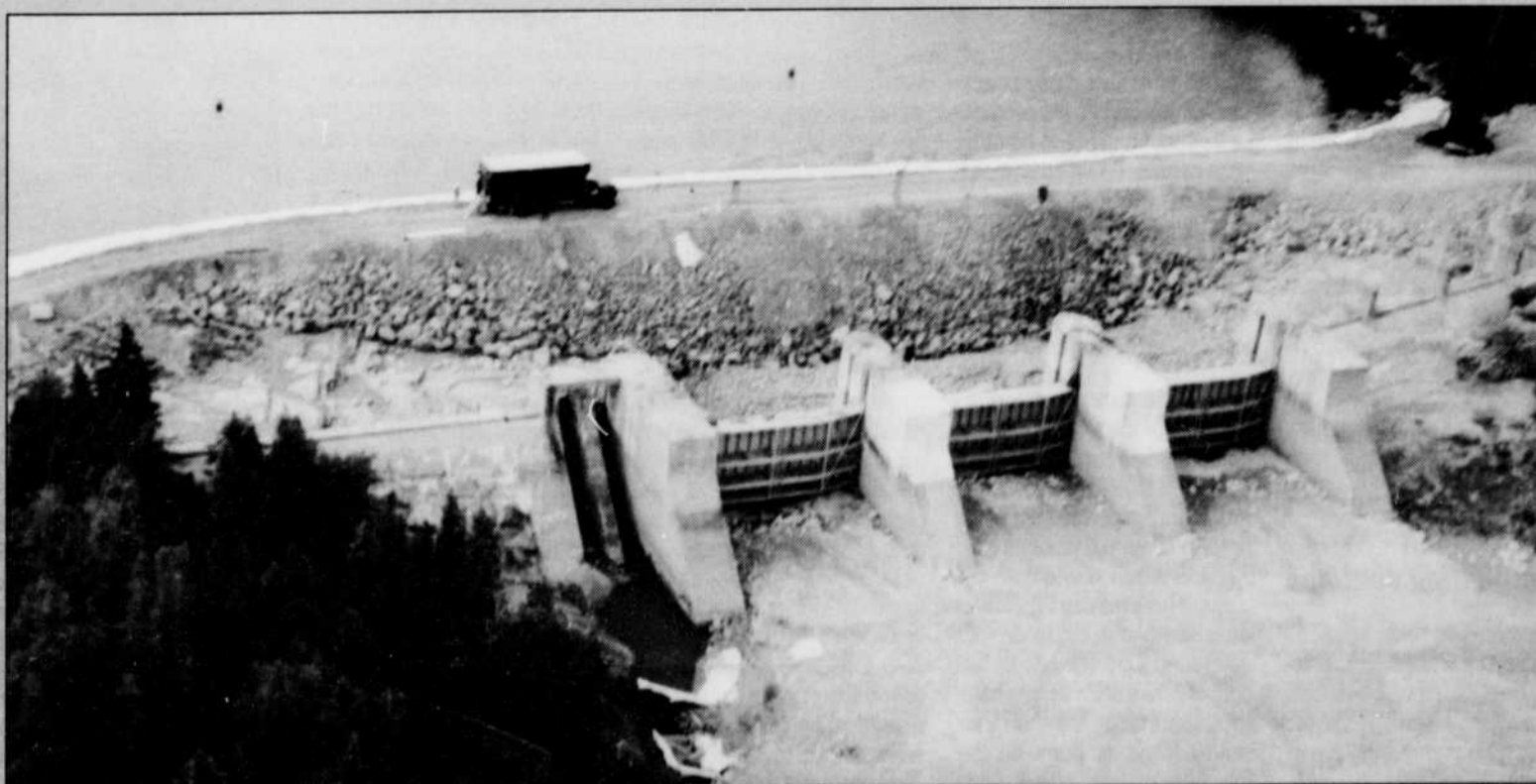
Le barrage no 7 avant les travaux de démolition alors que ce dernier était asséché par le batardeau.
