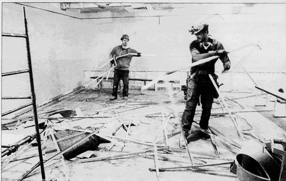
Des ouvriers s'affairent au nettoyage du rez-de-chaussée et du sous-sol de la bâtisse de la MRC du Fjord située à Saint-Honoré.
