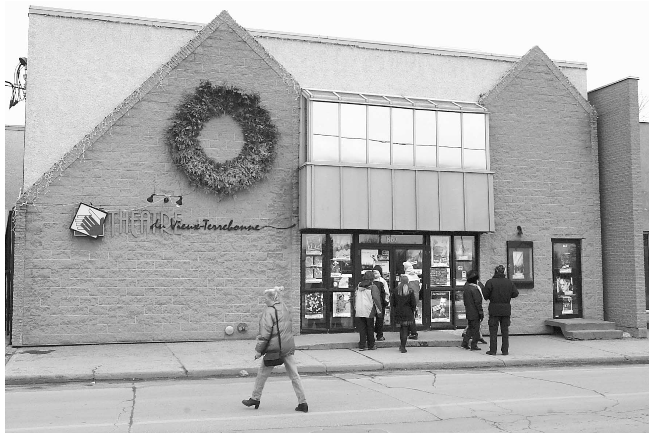
Le Théâtre du Vieux-Terrebonne date de 1947. Ses infrastructures et ses équipements techniques sont désuets et ne répondent plus aux attentes d'une clientèle en croissance.
