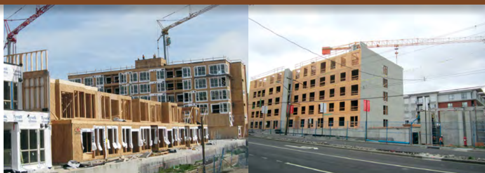
Figure 1 Bâtiments de moyenne hauteur à ossature de bois en Colombie-Britannique
