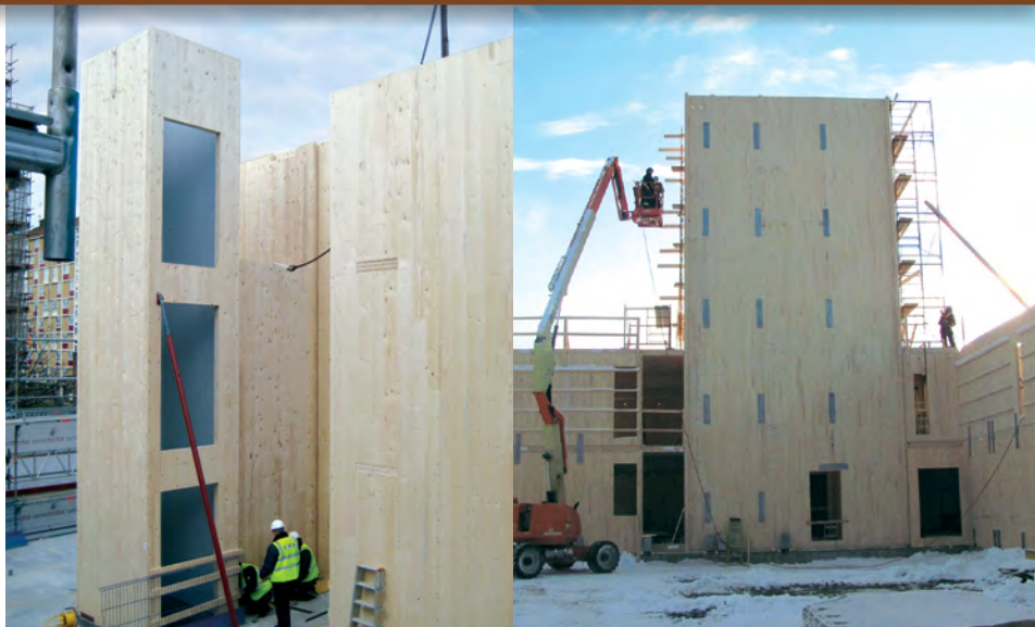
Figure 13 Murs de cage d'ascenseur construits à partir de bois lamellé-croisé
