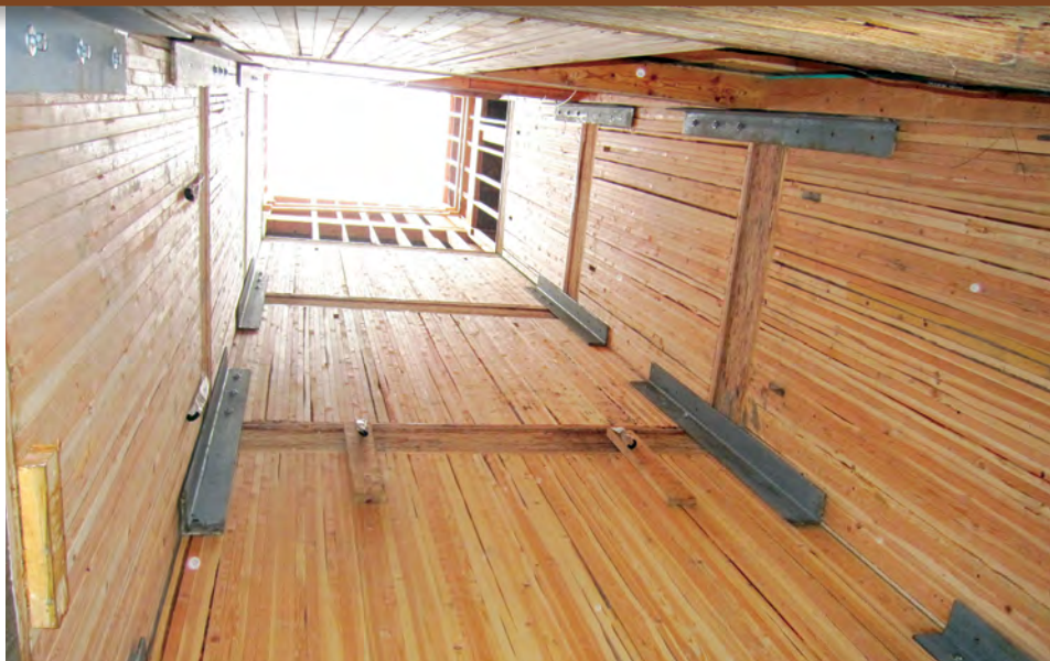
Figure 12 Murs de cage d'ascenseur construits à partir de bois massif
