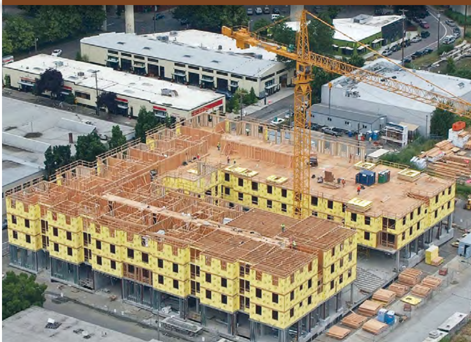
Figure 17 Construction de type podium à Portland, en Oregon (photo : Walsh Construction)
