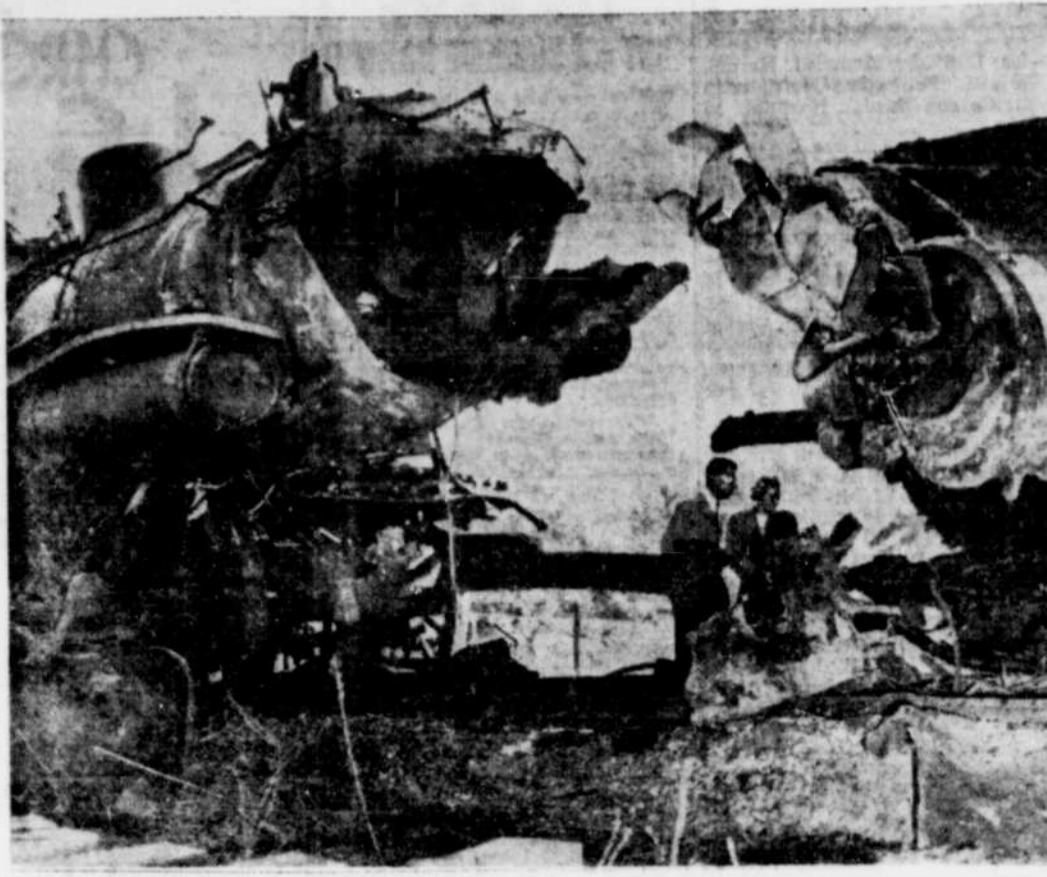
● Lorsque deux monstres d'acier se rencontrent, comme le firent les deux locomotives ci-dessus, près de San-Francisco, Californie, les désastres sont terribles. L'accident dont il est ici question s'est produit entre un train de voyageurs et un train de fret sur une ligne du Western Pacific Railroad; il a fait trois morts et 10 blessés.
