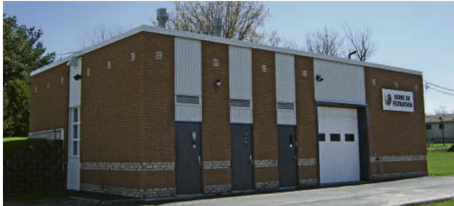
La Municipalité de Wickham a enfin réparé la fuite d'eau qui l'obligeait à émettre un avis d'ébullition préventif de façon permanente. (photo gracieuseté Municipalité de Wickham)
