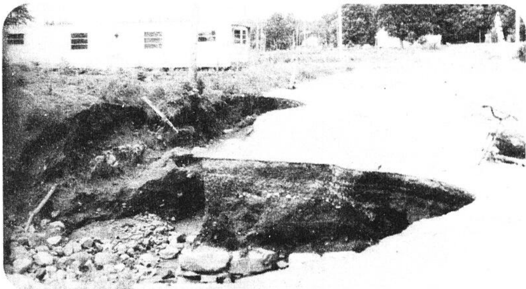
Les pluies diluviennes que notre région a connues au début de la semaine dernière ont causés d'importants dommages un peu partout. Ici, c'est une partie du chemin, dans le rang Ste-Catherine, à Saint-Cuthbert, qui s'est affaissé et des images semblables peuvent être vues en plusieurs endroits du comté. Les lourds dommages sont difficiles à évaluer pour le moment mais il est une chose certaine, les employés de la voirie ne chômeront pas au cours des prochains mois pour réparer les dégâts qu'a causés cette pluie "extraordinaire".
