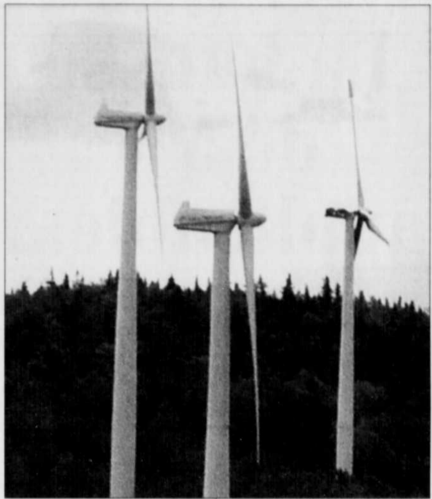
Les flammes ont détruit l'équipement mécanique et électrique situé dans la nacelle de l'éolienne, à droite de la photo.
