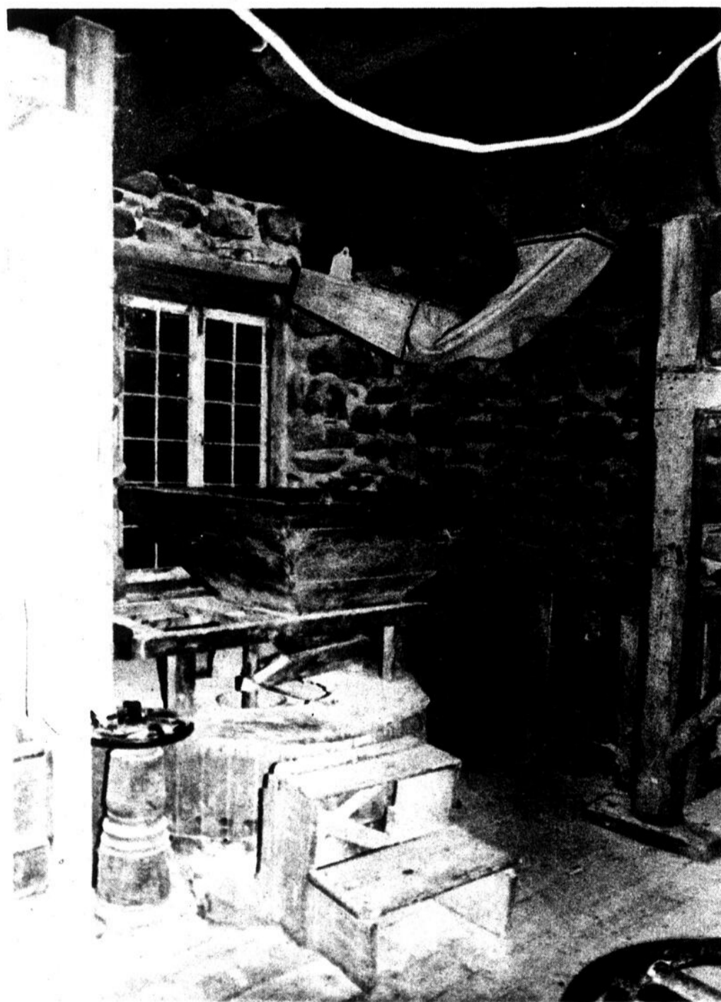
La trémie, cette auge à ouverture carrée dans laquelle on met le grain qui passe ensuite entre les meules...
