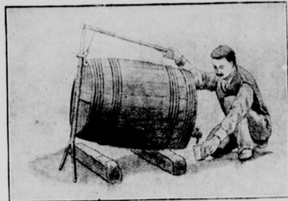
Appareil permettant de soulever les fûts en vidange et d'en soustraire le contenu sans aucun mélange avec la lie.
