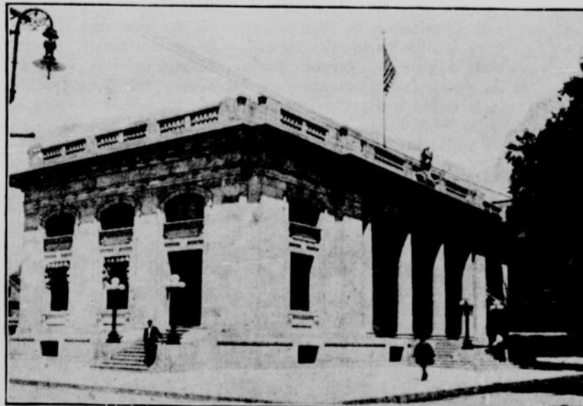
Le bureau de la poste est d'une architecture antique.
