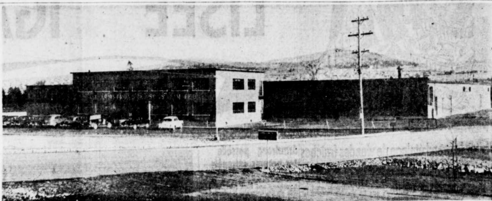
Un aperçu des vastes entrepôts et bureaux de G. T. Armstrong, situés rue King Ouest, à Sherbrooke. Cet édifice, vaste et moderne, répond adéquatement aux besoins de la maison Armstrong qui dessert le magasin IGA de votre voisinage.
