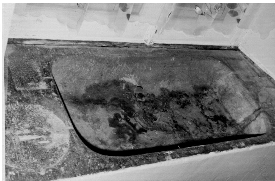
...la pierre d'eau, sorte d'évier d'ardoise à la base d'une fenêtre de la cuisine.
