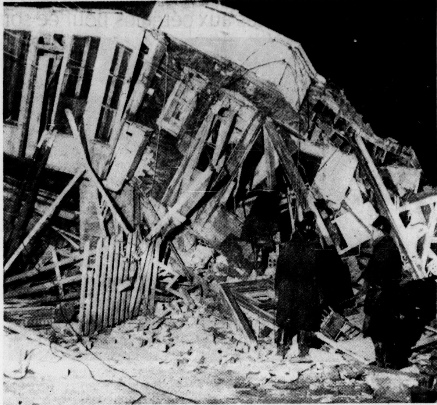
ILS CHERCHENT LA CAUSE: Des pompiers font l'inspection des ruines qui restent d'une maison de deux étages du nord-est de Montréal démolie par une puissante explosion samedi soir. Quinze personnes recurent des blessures et quatre ont été emprisonnées dans les débris.
