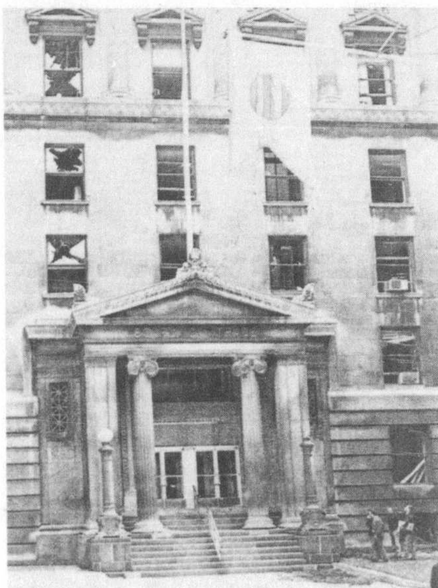
Aucune fenêtre du Board of Trade Building n'a résisté à l'explosion d'une bombe hier matin. Une douzaine d'immeubles du quartier des affaires de Montréal ont aussi subi pareils dommages. L'engin avait été déposé à l'extérieur de l'immeuble du 300 rue St-Sacrement, à droite de l'entrée principale sur notre vignette.
