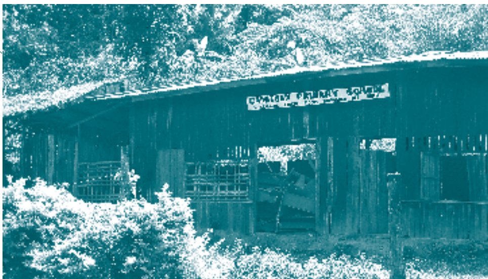
Escuela primaria construida por mineros subanon y mineros de pequeña escala. Ésta ha sido trasladada por TVI Resource Development a unos seis kilómetros de la comunidad y cerca de un puesto de seguridad de la milicia armada (SCAA).
