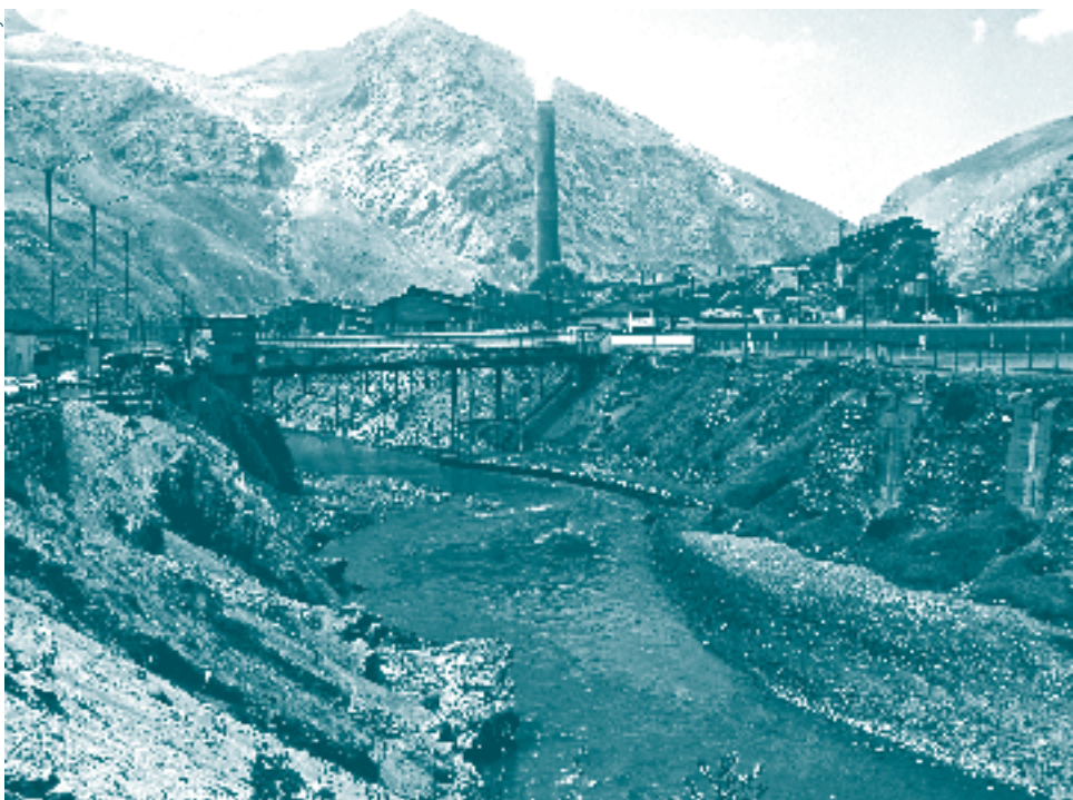
El puente histórico Cascabel, que antes era el acceso principal a La Oroya, vinculando la comunidad con el resto del país. Actualmente sirve solamente para los trabajadores de la empresa.
