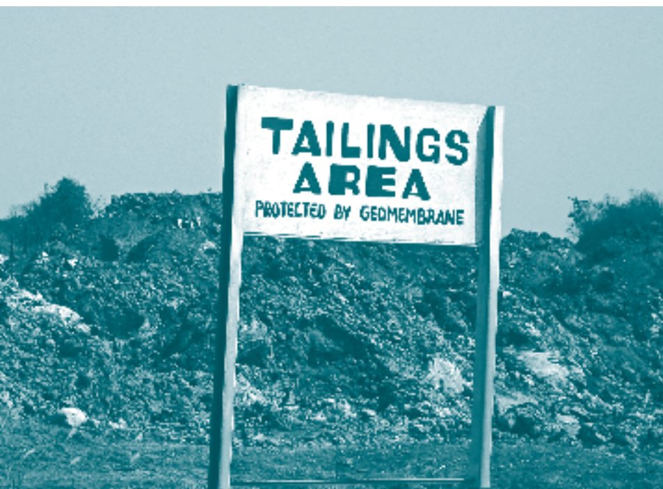
Emplazamiento de las instalaciones de SOMIKA. Los residuos protegidos por una geomembrana están rodeados por una red de drenaje enterrada directamente en el suelo.
