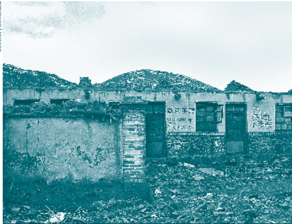
Alojamiento para trabajadores migrantes abandonado al lado de la vía férrea Gormo-Lhasa.
