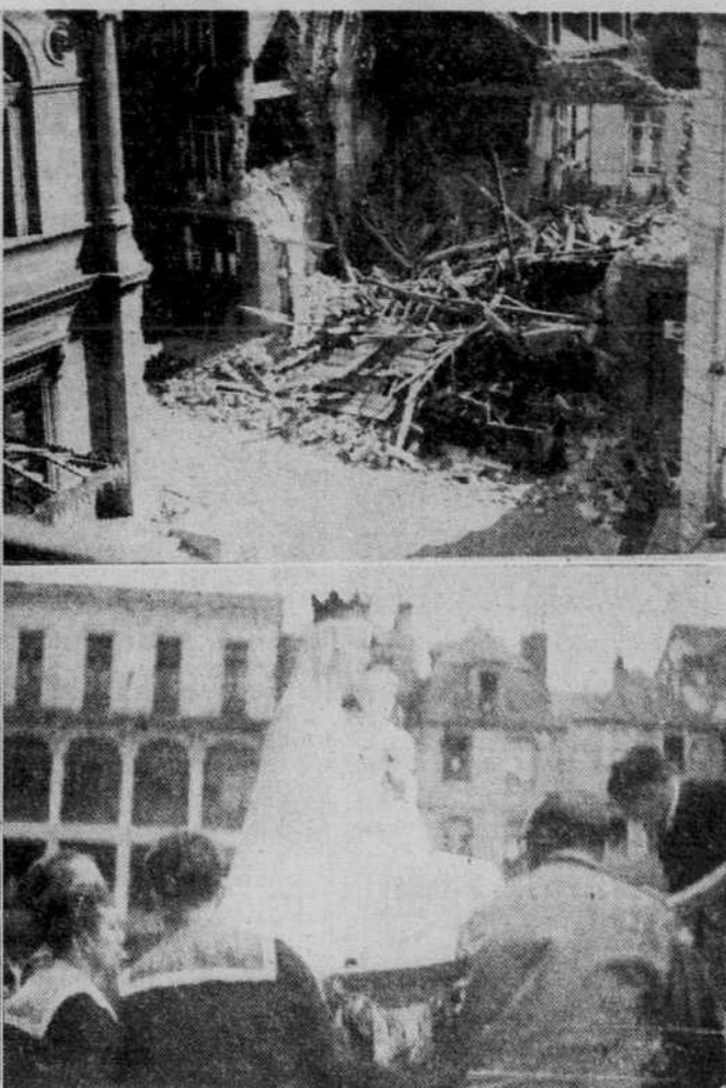
photographies du haut nous font voir ce qui reste de sa célèbre cathédrale. En bas, à gauche, on peut apercevoir la désolation qui règne dans le port; la photographie de droite, prise en temps de paix, nous montre une scène de la procession de «Notre-Dame de Boulogne», une statue miraculeuse qui attirait un grand nombre de pèlerins.
