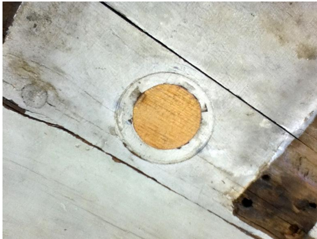
Rossignol, réalisé avec une pièce du bois circulaire collée et arasée en alignant le sens des fibres du bois.
