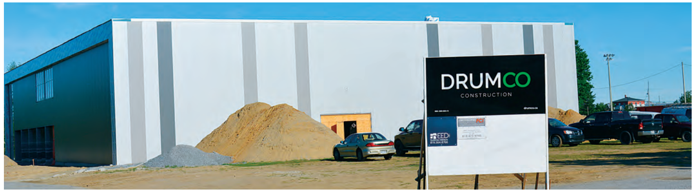
Le gymnase multifonctionnel, actuellement en construction, devait normalement accueillir Les Élans cet automne.
