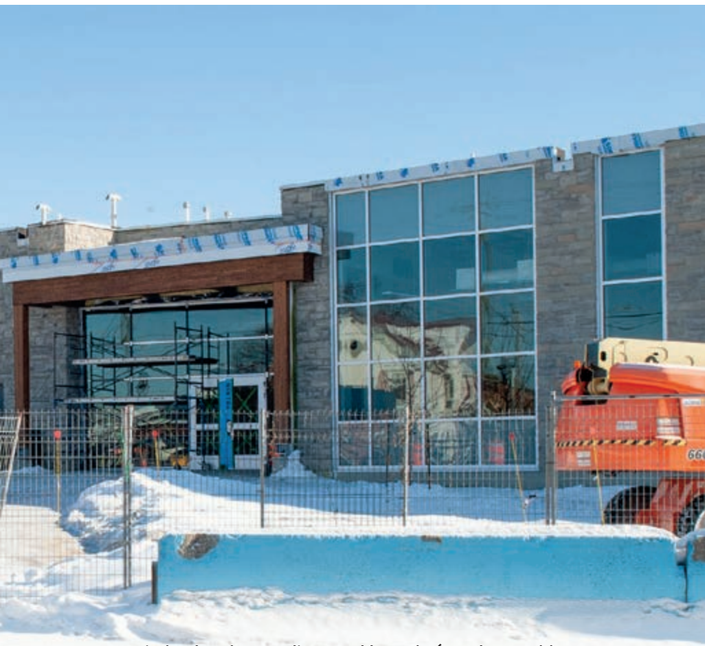
L'usine de traitement d'eau potable est située sur la rue Poirier. (Photo Ghyslain Bergeron)
