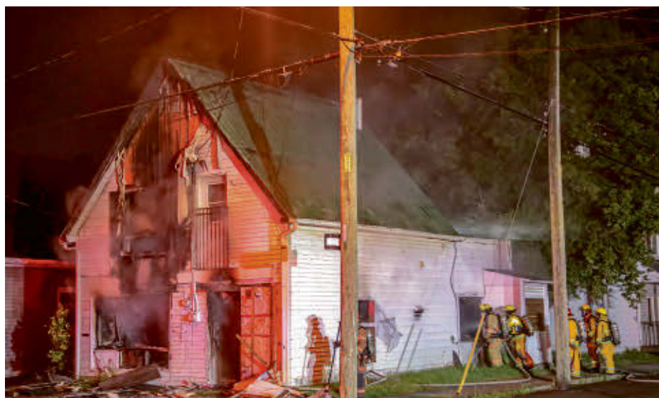
Ce quatrième incendie en à peine cinq mois, survenu le 25 juillet, a lourdement endommagé la maison, qui a finalement été démolie le 24 octobre. Photo Steve Gauthier | Les 2 Rives ©
