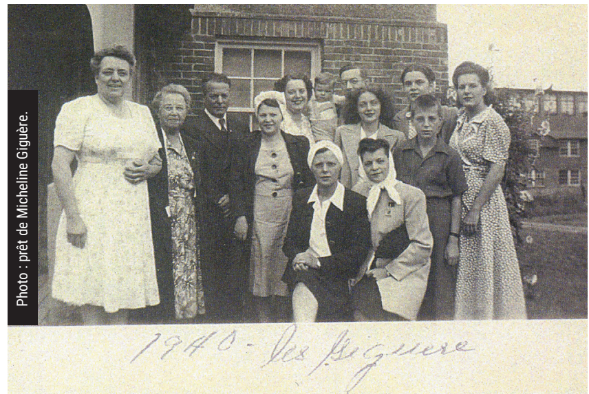
La famille Giguère de la rue Lincoln en 1940 prend la pose devant sa résidence. On remarque, derrière la dame de gauche, l'équerre qui supporte le petit toit du perron, une caractéristique architecturale des maisons de la Cité modèle.
