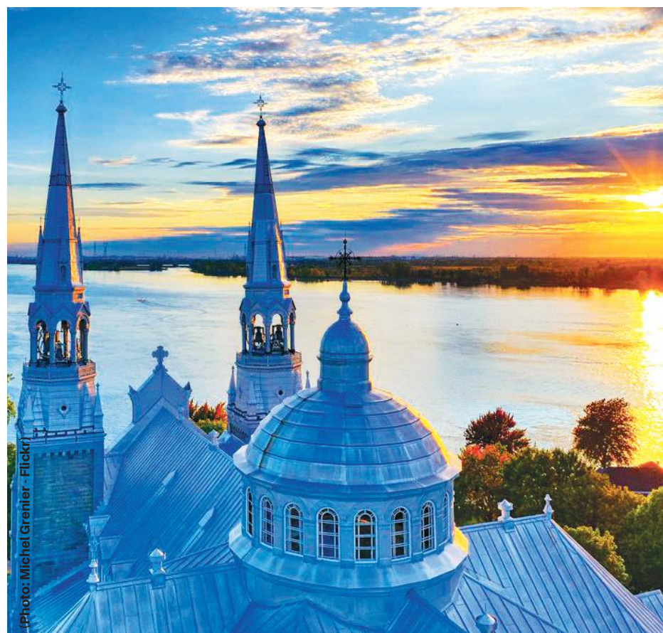
À Varennes, une somme de 70 000 $ sera allouée pour la restauration de la maçonnerie et des flèches des clochers de la basilique de Sainte-Anne.
