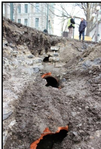
Photo 3 : Vestiges des canalisations retrouvées sous la fontaine, vers l'ouest. (Manon Goyette, 2012)
