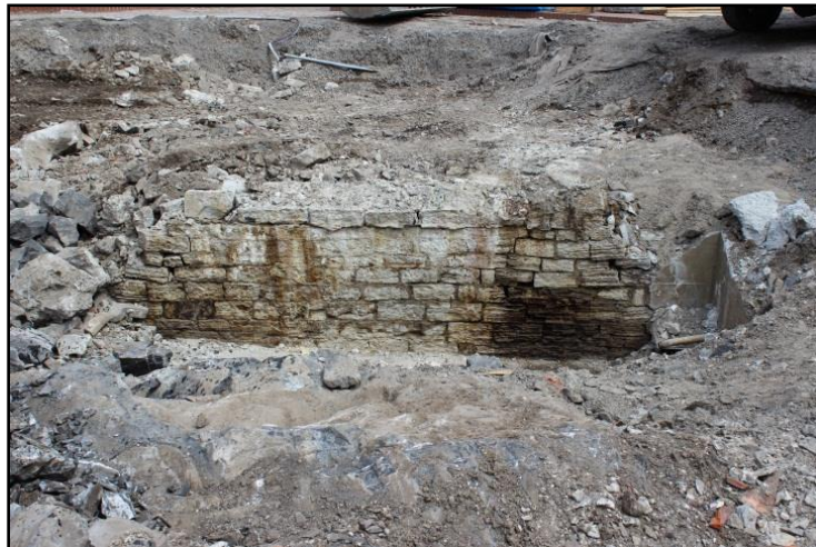
Photo 1 : Mur nord de l'accès à l'ancienne chambre mécanique de la fontaine (Manon Goyette, 2012).
