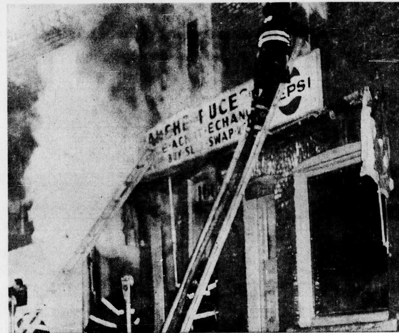
Le "Marché aux Puces", situé au 160 rue Wellington Sud, a été la proie des flammes tôt ce matin. L'alerte a été donnée par les personnes travaillant au Restaurant Rex, sis à proximité des lieux.
