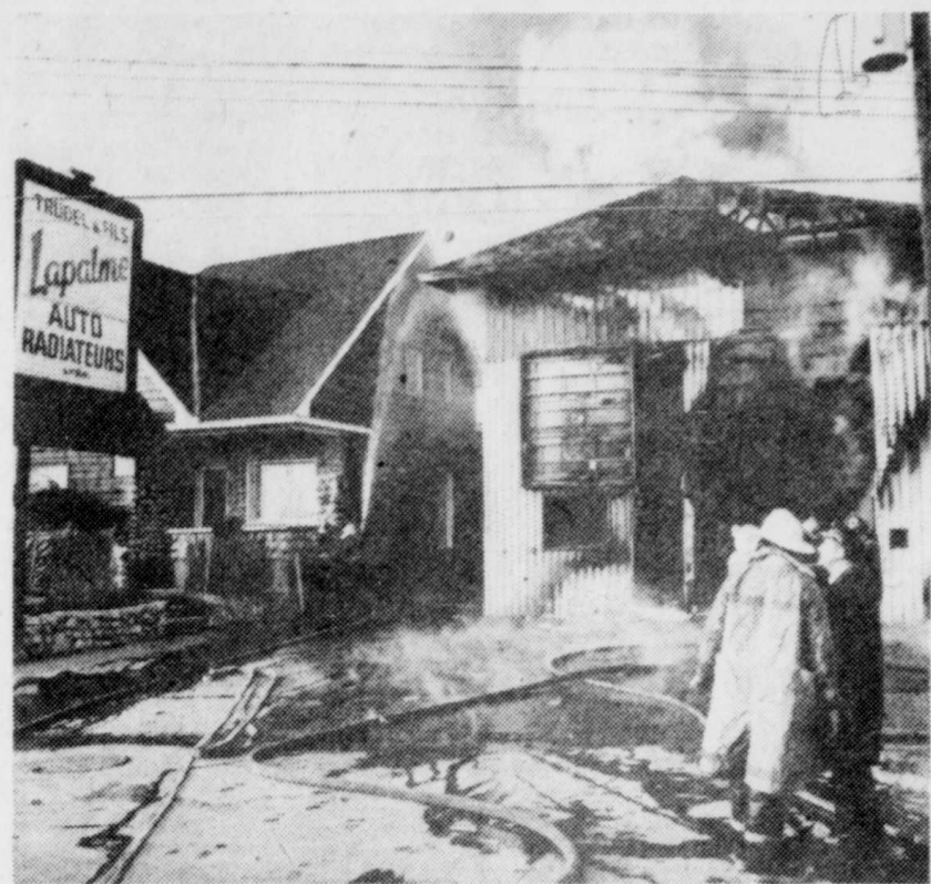
Les 15 pompiers présents sur les lieux de l'incendie, ont mis près de cinq heures pour maîtriser le brasier qui a complètement détruit le bâtiment commercial du Boul. Taschereau. Une émanation de vapeur d'essence serait à l'origine du sinistre. (Photo Claude Beaubien).
