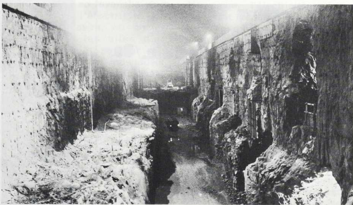
La salle des machines de la centrale de LG2 a été creusée dans le roc à 450 pieds sous terre.
