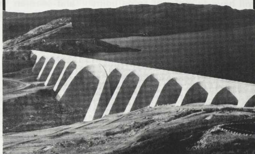
Le barrage Daniel-Johnson, à Manic 5
