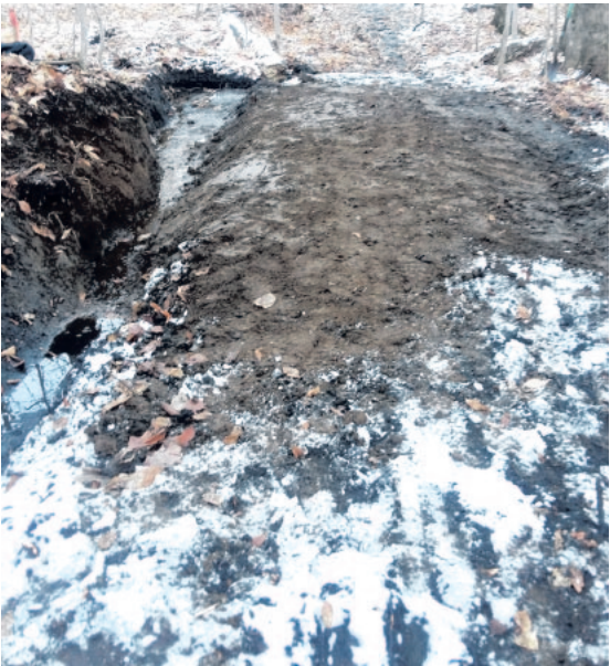
Amenagement d'un fossé d'une dizaine de mètres.
