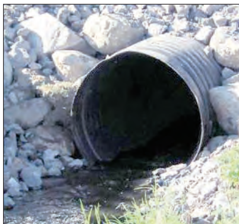
Ces travaux visent à préserver les extrémités du ponceau et du remblai.
