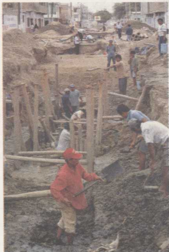
Pérou : réparation d'un système d'assainissement financé par la Banque interaméricaine de développement.
