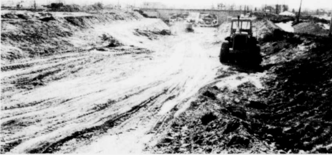
Viaduc en construction
